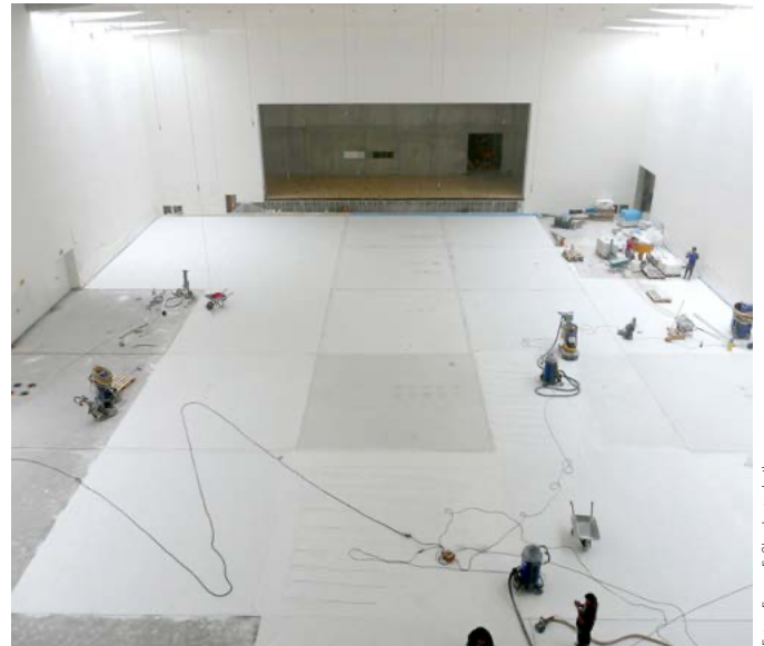
Das Foto zeigt Terrazzofelder im großen Saal in unterschiedlichen Bearbeitungsstadien.
