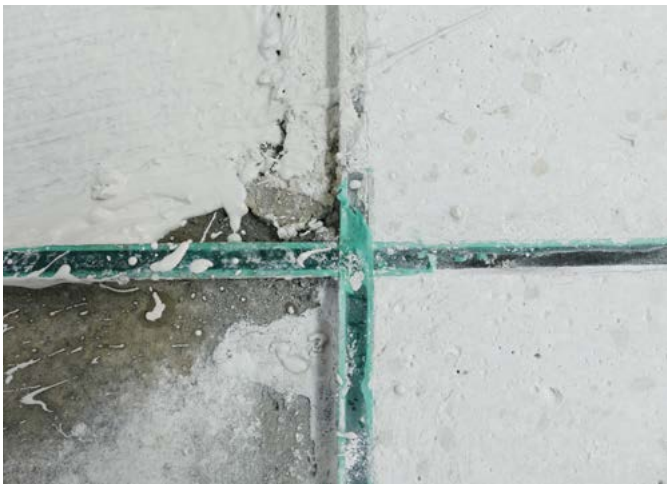
Das Fugenkreuz von Freese Fußbodentechnik sorgte für eine schachbrettartige Einbauweise der Estrichfelder.
