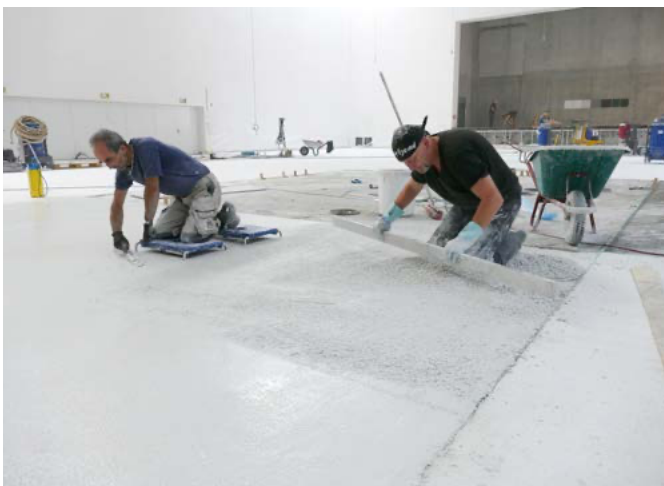
Das Abziehen und Glätten des Terrazzobodens lieferte ein optimales Ergebnis.
